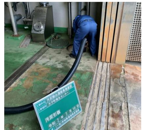
④指定箇所からの引抜作業
